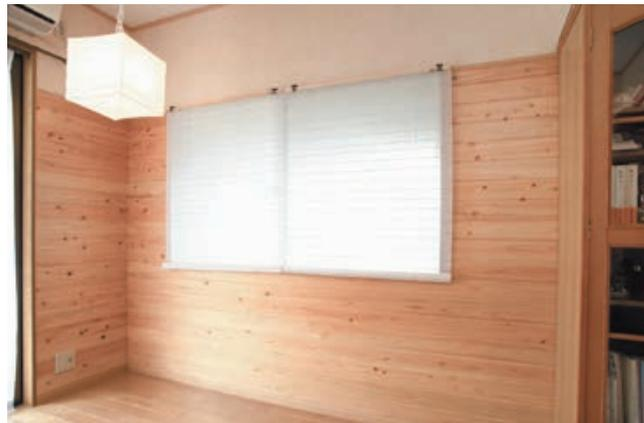
施工例：桧 羽目板（UV塗装）
