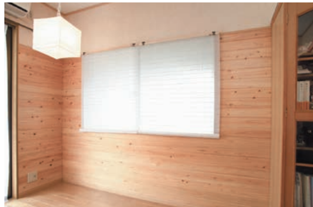
施工例：桧 羽目板（UV塗装）
